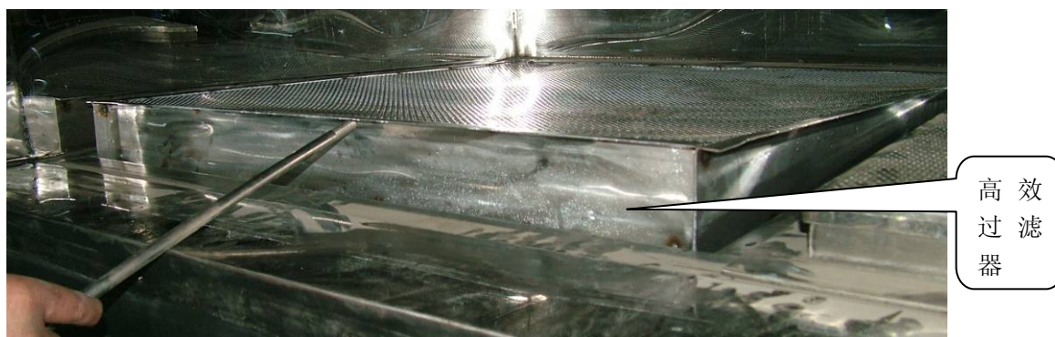
图 6-21 高效过滤器拆卸前或安装后
