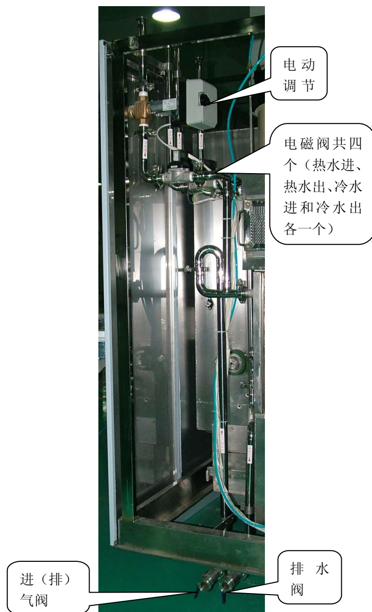
图 2-9 冷却区灭菌装置的管路
